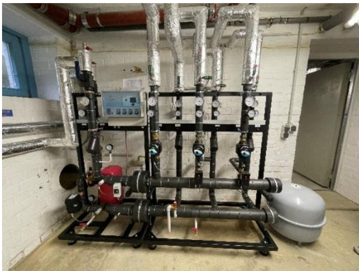
Anschlussstation Fernwärmenetz
