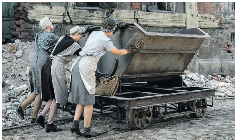
Die Frauen müssen den Schutt der Trümmerräumung in Loren laden. Sogenannte Trümmerbahnen bringen ihn dann auf Halden am Stadtrand.
