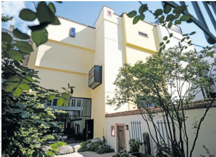
Der dreigliedrige Neubau mit einem gläsernen Erker schließt direkt an das Geburtshaus von Goethe (1749-1832) an.
