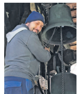
Ein Mitarbeiter der Firma Griwahn baut die alten Glocken in Züssow ein.
