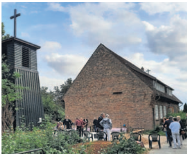
Die Grundplatte für den behindertengerechten Anbau an der Nordostwand des Slüterhauses in Dierkow liegt schon.
