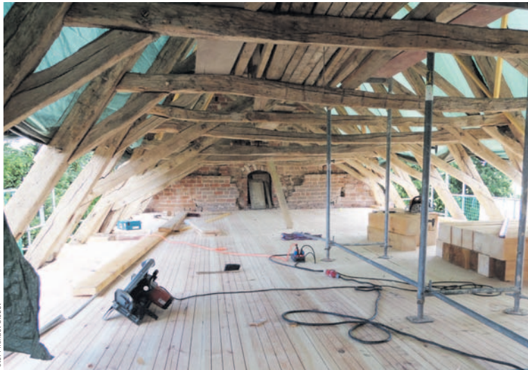
Der Dachstuhl der Weltziner Kirche stammt aus dem 15. Jahrhundert. Neue Balken verstärken ihn jetzt.
