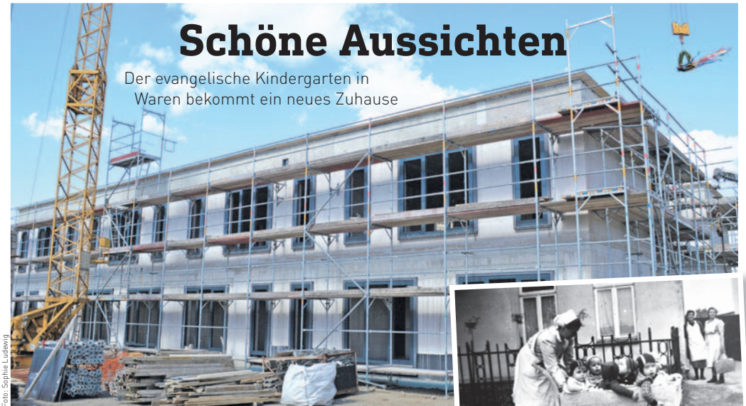
Richtfest in der Gievtzter Straße von Waren/Müritz. Hier entsteht das neue Kita-Gebäude.
