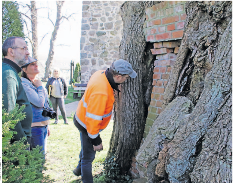
Vor längerer Zeit wurde das hohle Innere dieser Linde an der Witziner Kirche ausgemauert. Mit dem Wachstum der Linde fällt nun die Mauer auseinander. Stephan Birkholz (v.l.), Monika Albrecht und Dr. Horst Stobbe begutachten vor Ort.
