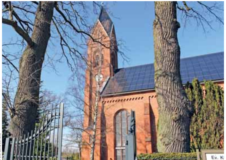
Eine Solaranlage auf dem Dach hat die Kirche in Greifswald-Wieck seit Jahren. Anlagen auf Kirchenland wären neu.
