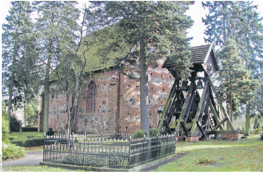
Der Glockenstuhl vor der Kirche in Garwitz in der Propstei Parchim soll saniert werden.
