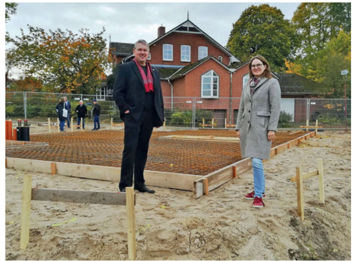
Vor der Bodenplatte des künftigen Heizhauses: Michael Eggers vom Kirchengemeinderat und Pastorin Anna Christ. Im Hintergrund steht das denkmalgeschützte Pastorat Foto: epd-bild/Nadine Heggen
