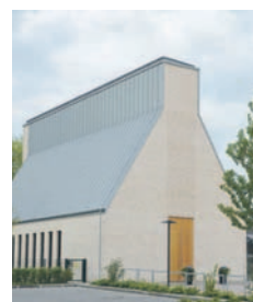
Wie der Himmel, so das Dach der Osterkirche. Foto: Katrin Jentsch
