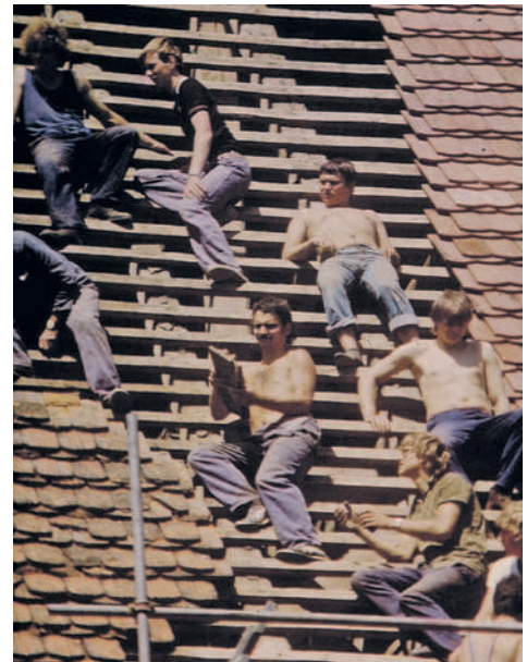
1984: Gemeindeglieder helfen in Feierabendarbeit beim Dachdecken der Kirche in Walkendorf. Foto: Archiv Günter Rein
