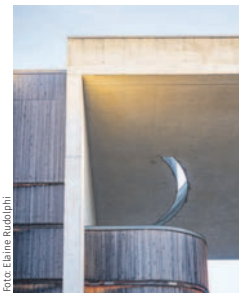
Lärchenholz und Kalkstein bestimmen den Bau.
