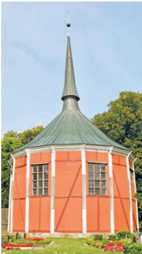
Der einzige 15-eckige Zentralbau im pommerschen Kirchenkreis: Nicht nur das macht den roten Fachwerkbau in Griebenow so einmalig.
