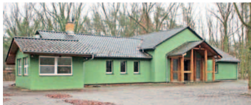
Die ehemalige Gaststätte „Löcknitzer Bär“ wurde im Auftrag des Erzbistums Berlin grundlegend saniert und umgebaut.
