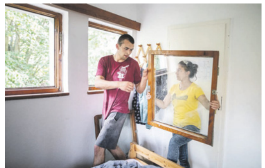
Durchblick: Die alten Fensterrahmen wurden von den jungen Leuten abgeschliffen, die Fenster neu verkittet und geputzt.
