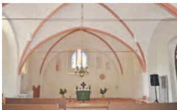
Das Innere der Kirche wurde im vergangenen Jahr für rund 300 000 Euro saniert.
