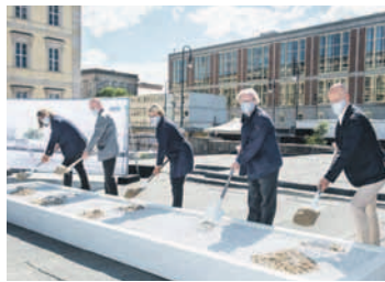
Spatenstich für den Bau des Berliner Freiheits- und Einheitsdenkmals. Foto: epd-bild/Christian Ditsch
