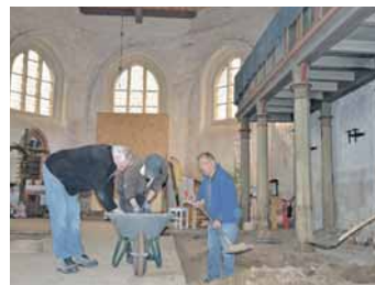
Freiwillige aus Züssow halfen, den Boden in der Kirche auszusachften. Archäologe Dirk Brandt aus Greifswald begutachtete den Erdaushub.
