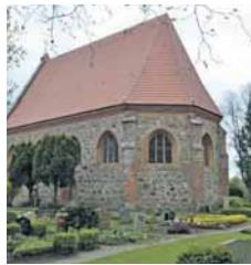
Die Außensanierung ist fast fertig.
