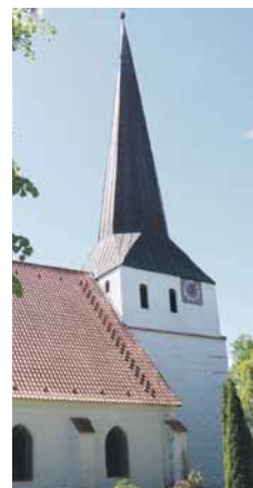
Das Dach soll als nächstes repariert werden. Foto: wikipedia
