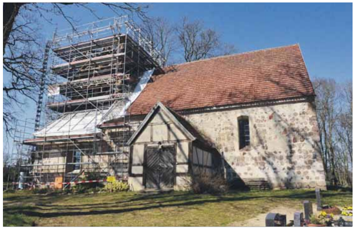
Fast vollständig hinter dem Baugerüst verschwunden: die Fachwerkkonstruktion des Turmaufbaus der Kirche in Lichtenberg. Fotos (2): Hans-Joachim Kohl
