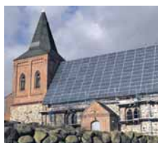
Auch in Zernin ist die Kirche mit Photovoltaik-Platten belegt.
