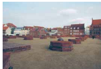
Das Langhaus der 1945 zerstörten und 1960 abgerissenen Marienkirche in Wismar ist bis zu einer Höhe von 80 Zentimetern aufgemauert. Foto: Marion Wulf-Nixdorf
