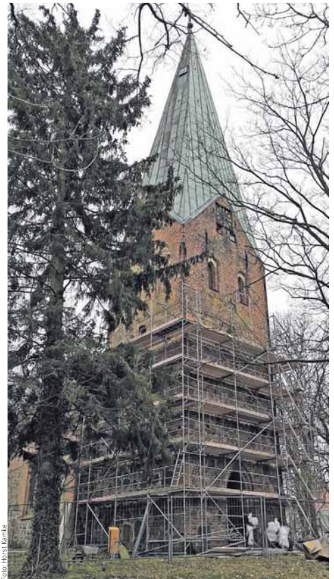
Der Kirchturm in Spornitz ist eingerüstet und wartet auf seine Sanierung.
