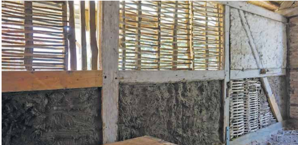
Aufwendige Arbeit: Die Lehmwände der Pfarrscheune werden auch wieder in Lehmbauweise restauriert.
