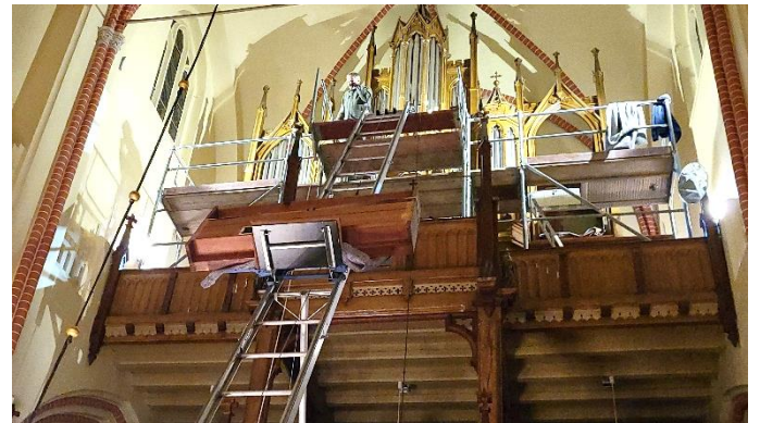
Arbeit in luftiger Höhe
