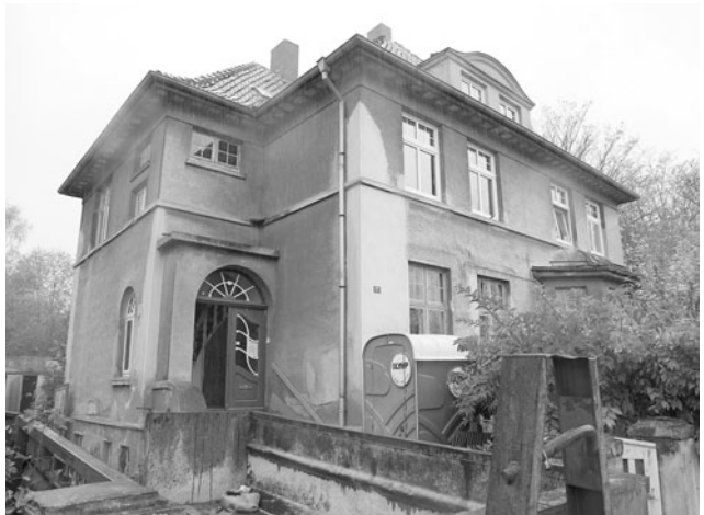
Das Gundlach-Haus in der Lübschen Straße wurde saniert, um es als Unterkunft für Obdachlose eröffnen zu können.
