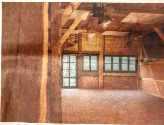
Im modernen Festsaal der Pfarrscheune wurde eine moderne Musik- und Lichanlage verbaut.
