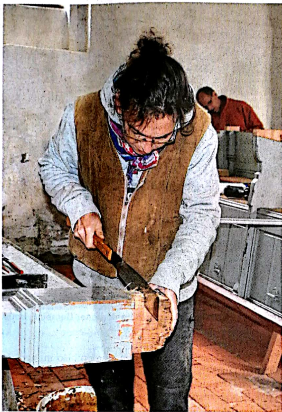
Lina Keßler kürzt die Verankerung einer Kirchenbank ein, denn auch da hatte die Feuchtigkeit in der Trebbower Dorfkirche Wirkung gezeigt.
