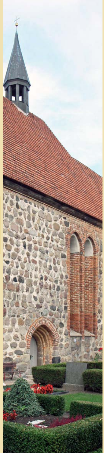
Neu eingedeckte Kirche in Cammin
