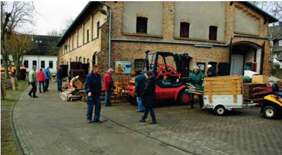
Um mit dem Umbau der Pfarrscheune beginnen zu können, mußte diese am 24. März vollständig ausgeräumt werden.
