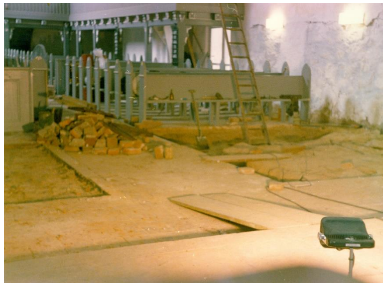
Abb. 11: Einbau einer Fußbodenheizung Foto: Ev.-Luth. Kirchengemeinde Dassow
