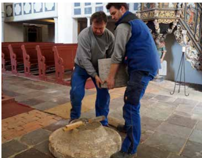
Jens Eichhorst (links) und Eric Eichhorst vom Steinmetzbetrieb Eichhorst setzen das neu angefertigte Mittelstück der Taufe auf den noch erhaltenen historischen Fuß.
