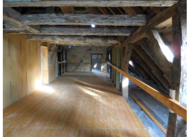
gedämmte Decke und Wand und neue Laufebene im Obergeschoss
