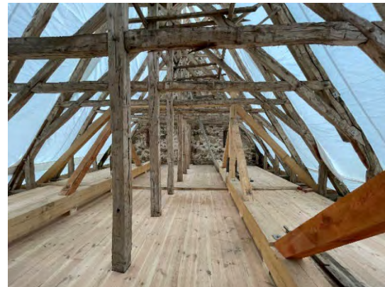
nachgerüstetes Hängewerk
