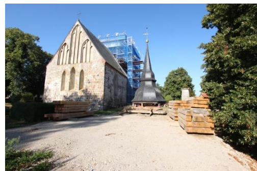
Neuaufbau des Turmes ab dem 2. Turm-OG
