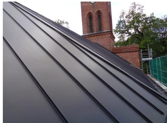
Metalldacheindeckung (vorbewittertes Zinkblech)
