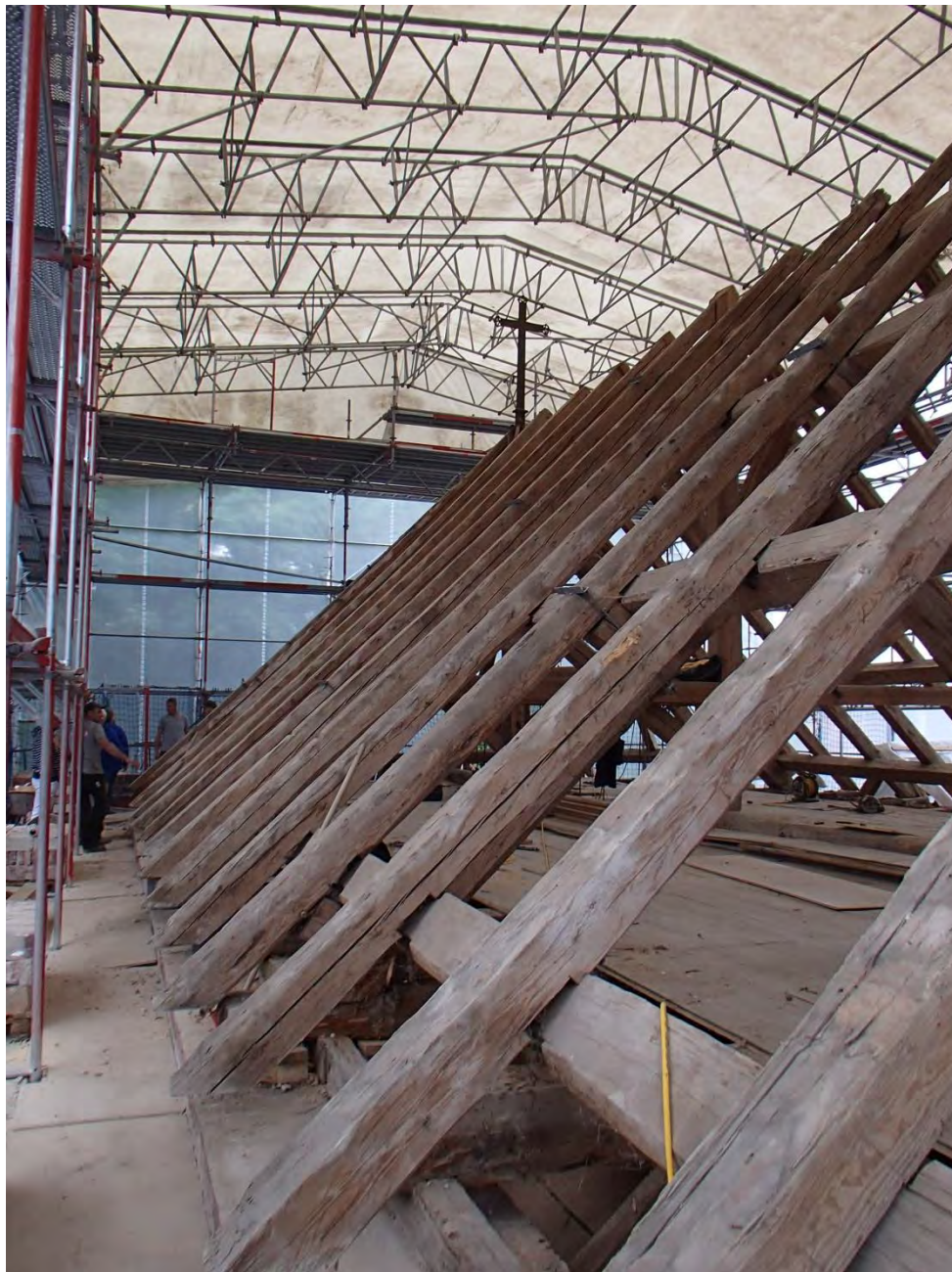
Kirche Spornitz – Damit der Dachstuhl saniert werden kann, musste, aufgrund der komplexen Schäden, eine vollständige Einhausung aus Gerüstbauteilen hergestellt werden.
