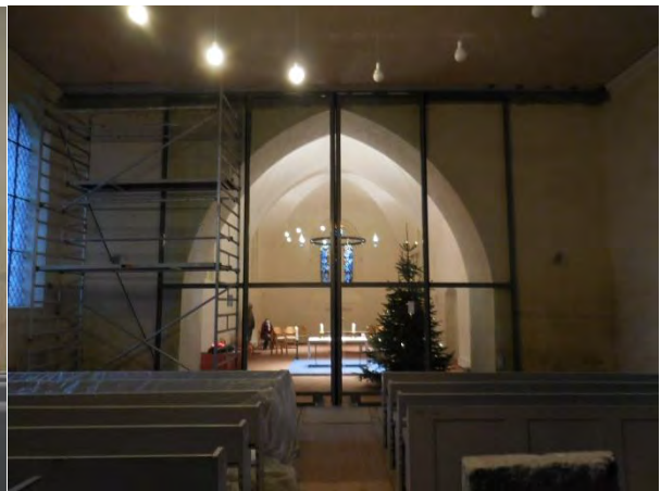
und mit Glasschiebewand kurz vor Fertigstellung
