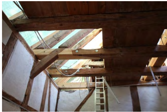
Instandsetzung der Dach- bzw. Deckenkonstruktion
