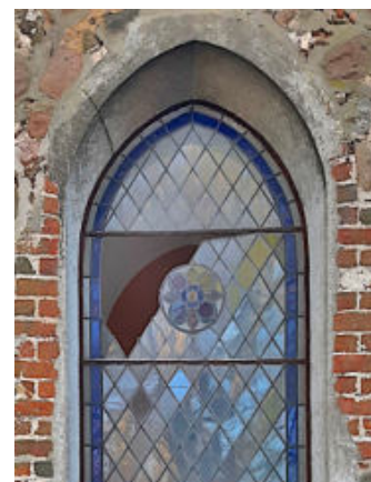
Die Schäden an der Nord- (o.) und Südseite (re.) entstanden während des Sturmtiefs im Februar 2022; der Wind hat die Scheiben einfach eingedrückt. [KT]
