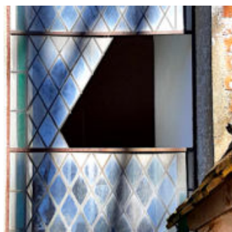
Die Schäden an der Nord- (o.) und Südseite (re.) entstanden während des Sturmtiefs im Februar 2022; der Wind hat die Scheiben einfach eingedrückt. [KT]
