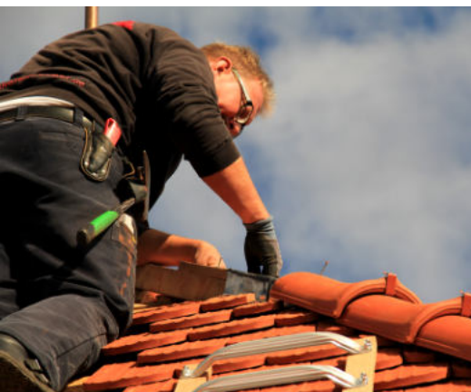
Jan Schätzchen von der Fa. Krüger beim Eindecken auf dem höchsten Punkt in Unter Brüz. Rechts sind die neuen Dachziegel und ein Teil der Schallluken sichtbar. [Fotos: JB]
