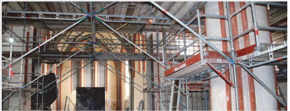
Blick in den jetzt gerüstfreien Ostchor
