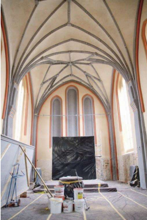
Blick in den Ostchor. Die linke große Holz-Paneele kann im Gegensatz zur rechten vom Tischler renoviert werden
