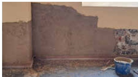
Putzarbeiten in der Kirche Schwandt Foto: 3KfV Rosenow-Schwandt-Tarnow
