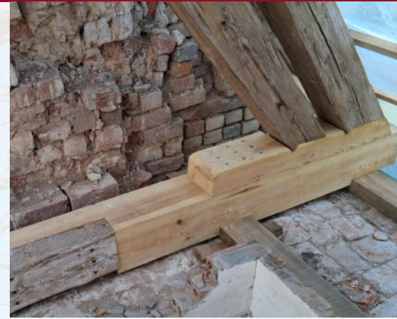
Alt und neu nah beieinander – nach Möglichkeit werden historische Bauteile erhalten und nur da wo es notwendig ist, durch neue ersetzt. [JB]
