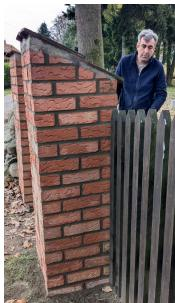
**Die Pfeiler am Haupttor in Dammwolde** wurden neu verfügt. Darüber hinaus wurden die Ziegel gereinigt und die Aufhängungen der Tore stabilisiert. Gute Arbeit!
