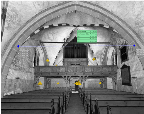
Lage des einzubauenden Zugankers
