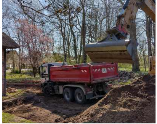
Schwere Technik bei Beginn der Arbeiten Ende April
