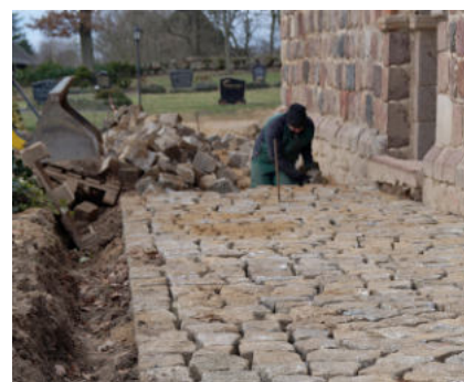
Pflasterarbeiten in Benthenthen auf der Südseite der Kirche.
