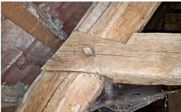
passgenaue Zimmermannsverbinding " halber Schwalbenschwanz"
