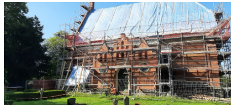
Fortschritt beim neuen Kirchendach in Walkendorf. Fotos: Anja Kiesow
