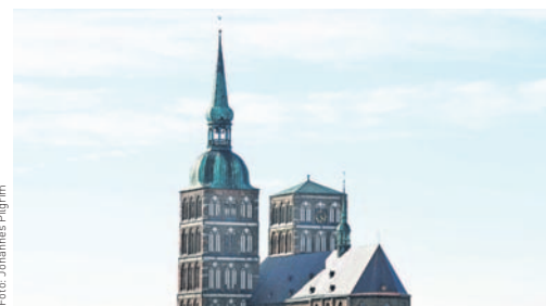
Mächtig thronen sie über Stralsund: die Türme von St. Nikolai. Doch der Schaden an ihnen ist gravierend. Besonders der Südturm (L.) ist betroffen.
