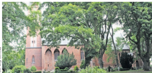
Die Kirche in Prohn bei Stralsund ist ein Kulturdenkmal.
