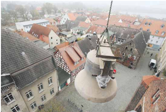
Hoch über der Peenestadt schwebt eine der vier alten Glocken aus 33 Metern Höhe vom Kirchturm herab. Anfang November machten sie Platz für neue Bronzeglocken, die am Wochenende ihren Dienst antreten.
