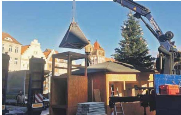
Das Teure an der Adventskapelle ist die Montage: Jedes Jahr müssen die Einzelteile mit Hilfe eines Krans aufgestellt und montiert werden. Das kostet rund 4000 Euro. Foto: Hans-Martin Harder
