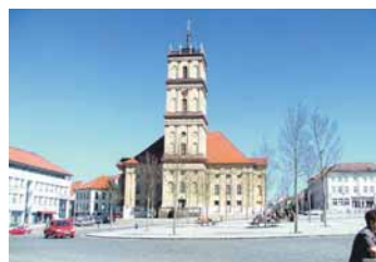
Bereits Anfang Oktober fand der Einbruch statt, der das Innere der Neustrelitzer Stadtkirche stark verwüstet zurückließ. Foto: Archiv
