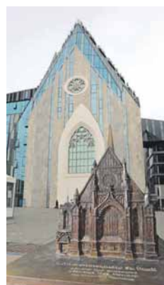
Bauarbeiten an St. Pauli sind abgeschlossen.
