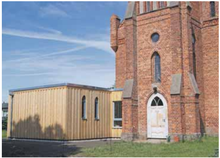
LAGERRAUM, TEEKÜCHE UND SANITÄRANLAGEN wurden an die Kirche in Rosenow angebaut.
