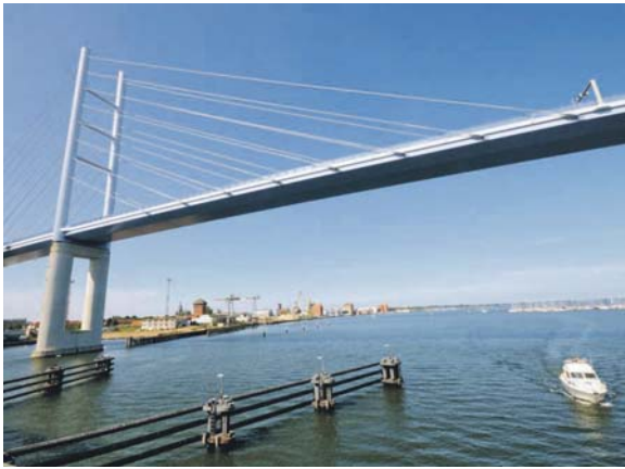
Die große Rügenbrücke: wahre Meisterin im Lastentragen und -verteilen.
